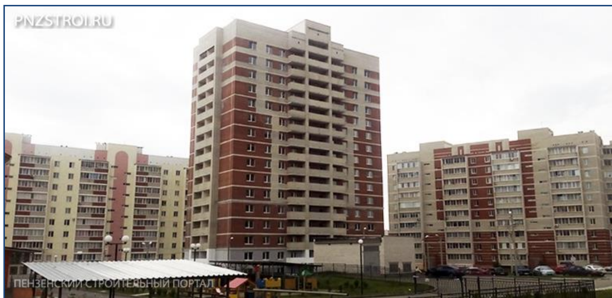
Рисунок 3. Жилой дом, в котором расположен оцениваемый объект (д. 148А)
